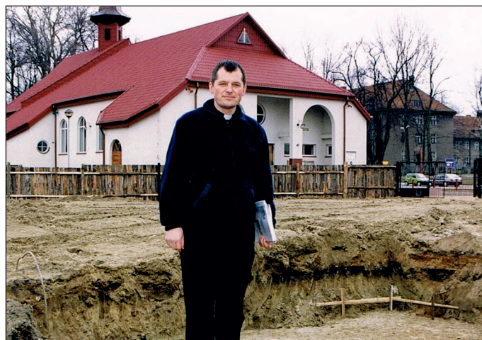
Skoro kościół już stoi, można pomyśleć o plebanii. Ksiądz Kazimierz Gryboś, długoletni proboszcz parafii p.w. Ducha Świętego Pocieszyciela w Giżycku, na placu budowy
