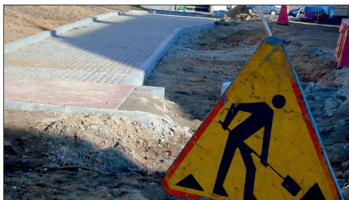
Budowa pasażu przy kościele ewangelickim
