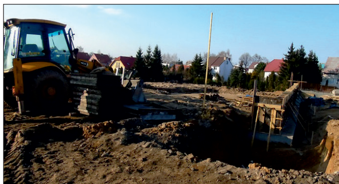
Budowa kompleksu sportowo - rekreacyjnego na Wilanowie
