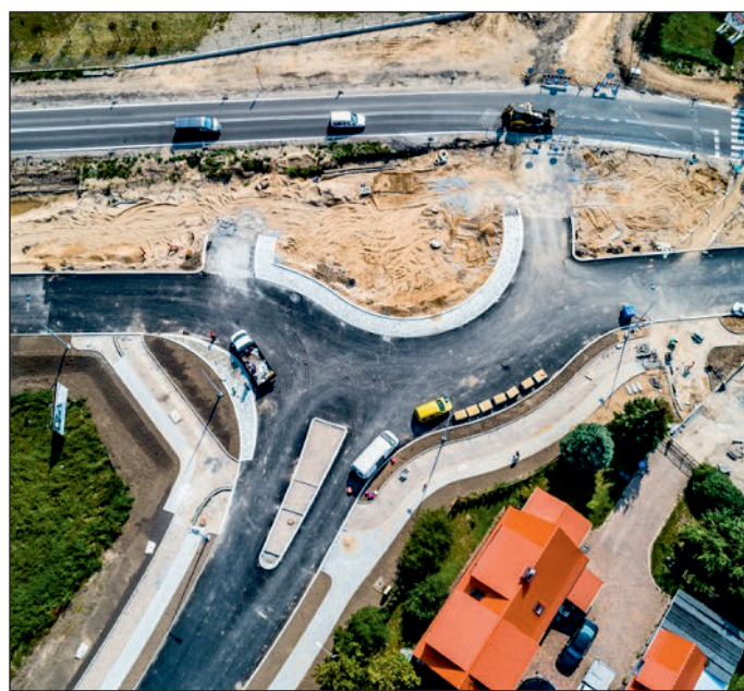
Rondo w budowie. Na dole zdjęcia widoczny wjazd na ul. Świderską
