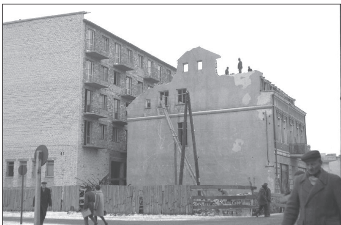
Rozbiórka domu przy ul. Obrońców Stalingradu (dziś Olsztyńska). Z lewej budynek, w którym mieści się m.in. bar „Omega”
