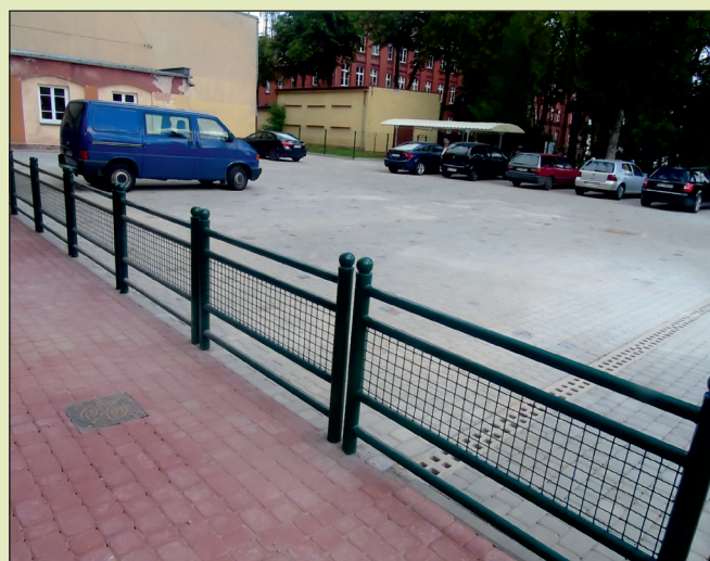
Na placu przed szkołą ułożono estetyczną kostkę
