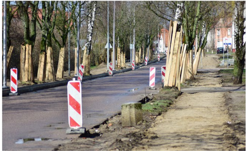
Rozpoczął się remont ulicy Sikorskiego. Za kilka miesięcy oczy mieszkańców cieszyć będzie nowa jezdnia, chodniki i oświetlenie. Podobnie będzie na sąsiedniej ulicy 3 Maja
