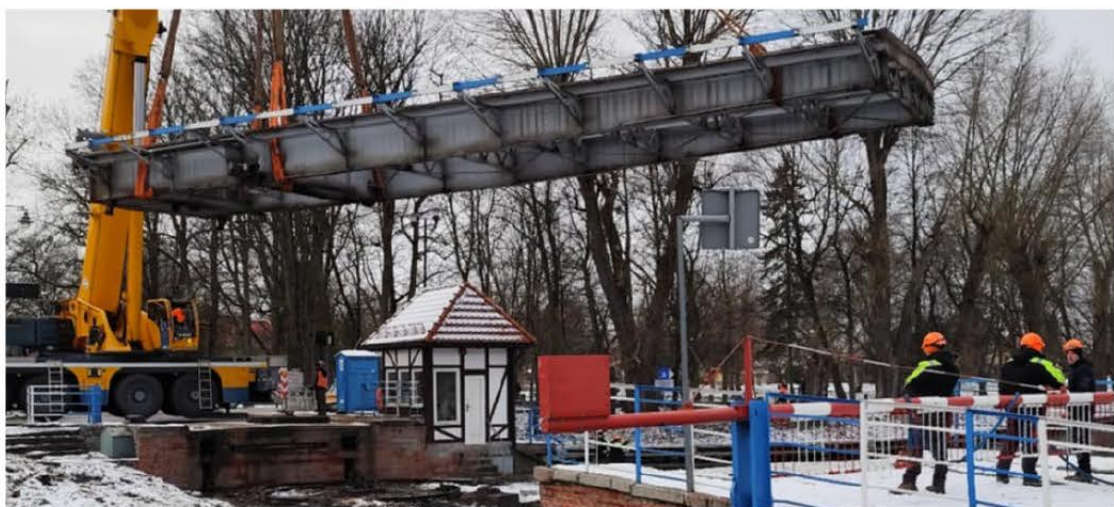
Znad kanału most zniknął w połowie stycznia. Jeśli nic nie stanie na przeszkodzie zostanie ponownie zamontowany w czerwcu.
